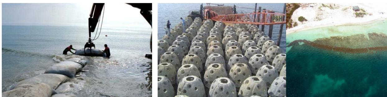
Fig. 13- 14 - Geosacchi e Reefball (Fonte: Linee guida per la gestione integrata delle spiagge, 2013)
